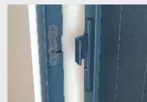
Gâche électrique et poignée de tirage extérieur
